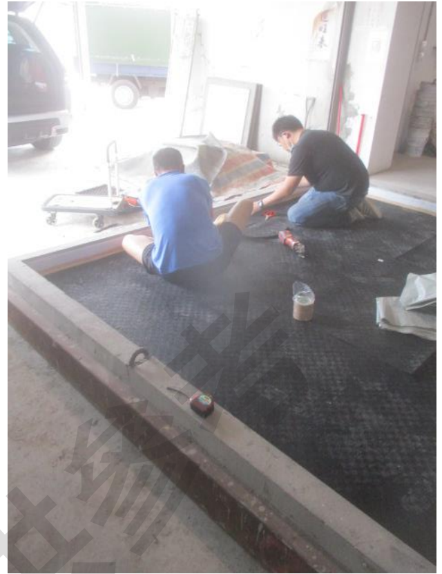
照片 6 試驗件組裝過程(鋪設隔音墊)
