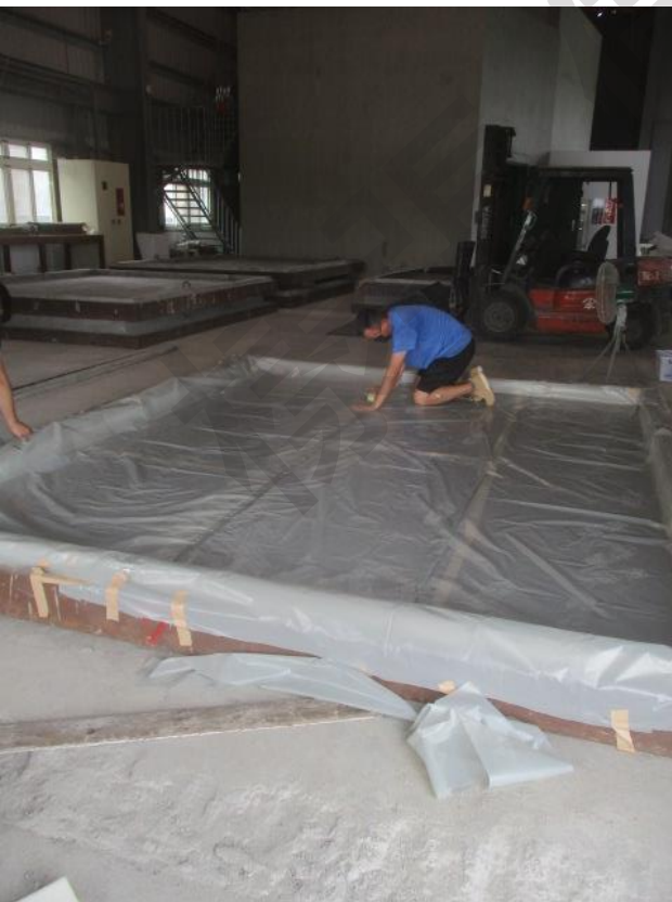
照片 7 試驗件組裝過程(鋪設防水墊)
