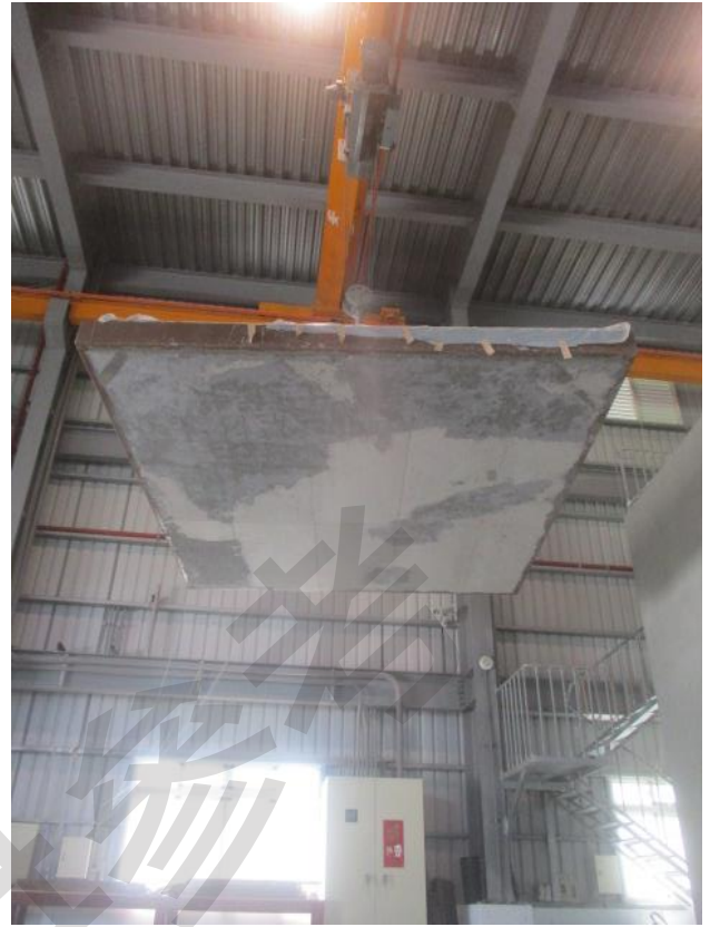
照片 10 試驗件施工完成背面
