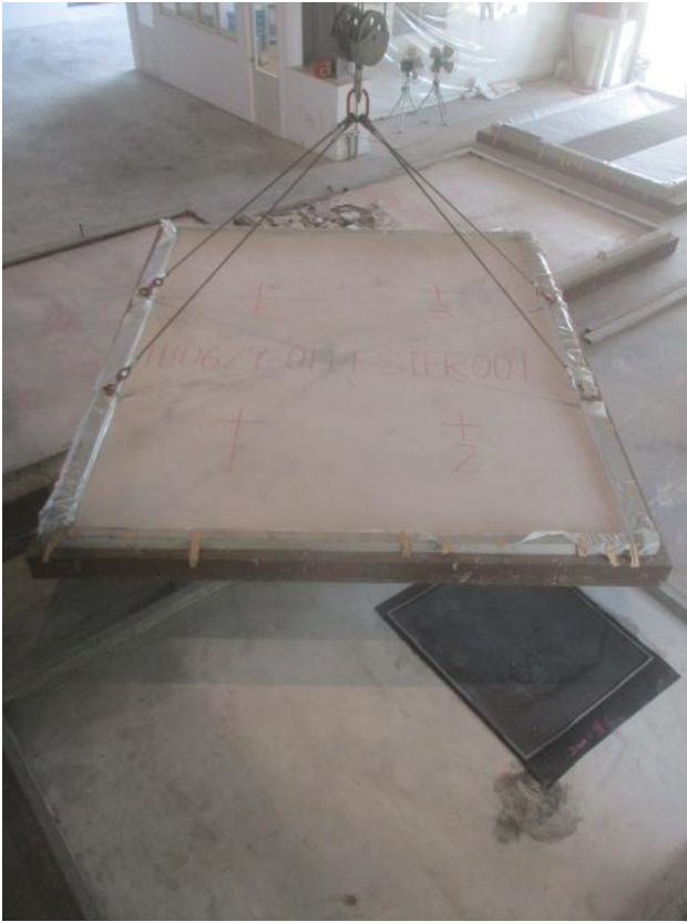
照片 9 試驗件施工完成正面
